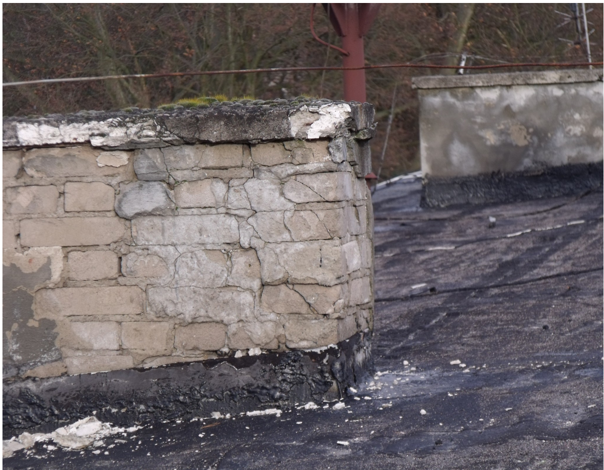
Fot.6.Widok kominów budynku. Widoczne spękania cegieł, oraz zmurszałe i zawilgocone cegły i czapki kominowe.
