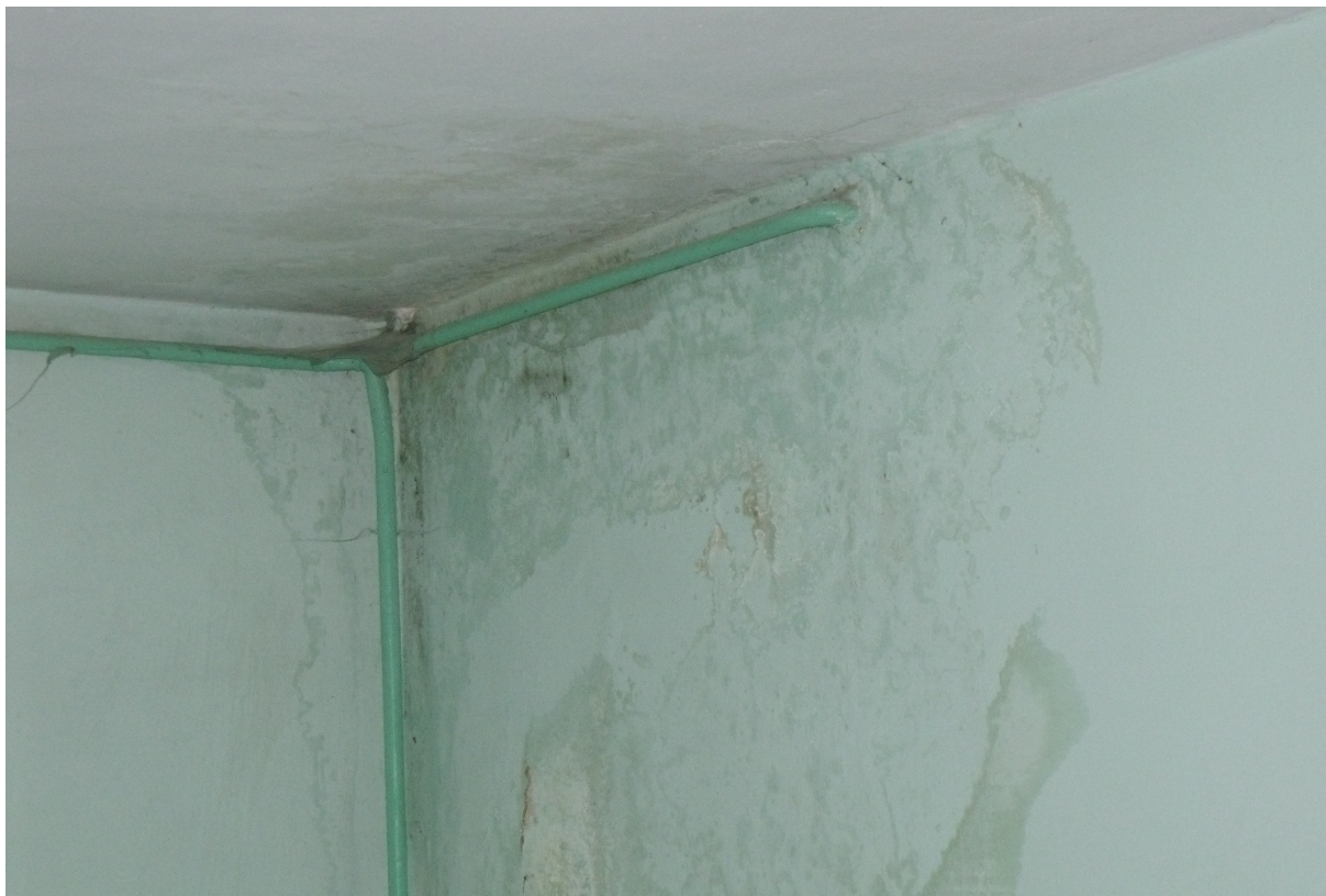
Fot.7.Widok zawilgoconych i zagrzybionych ścian 2 piętra od zacieków z dachu.
