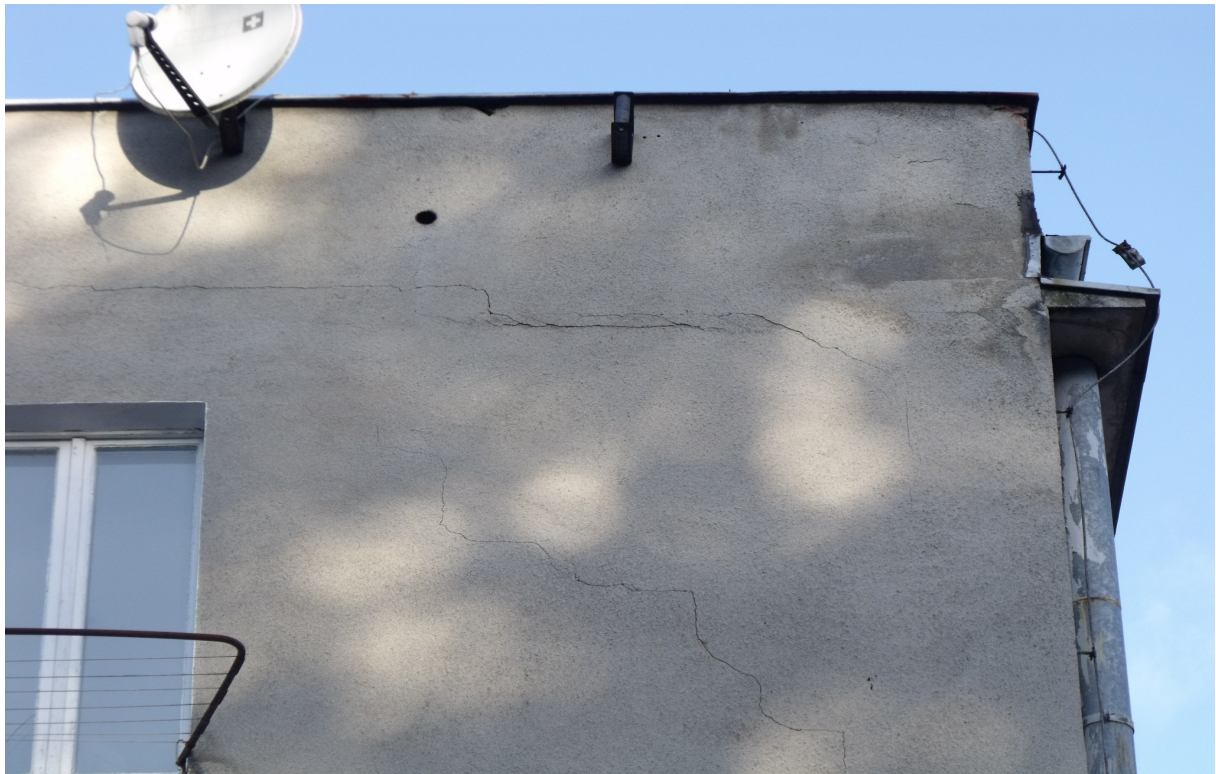
Fot.3.Widok attyki na szczycie budynku. Widoczne poziome i ukośne zarysowania na skutek ruchów termicznych stropodachu w związku z brakiem izolacji i dylatacji płyt korytkowych.
