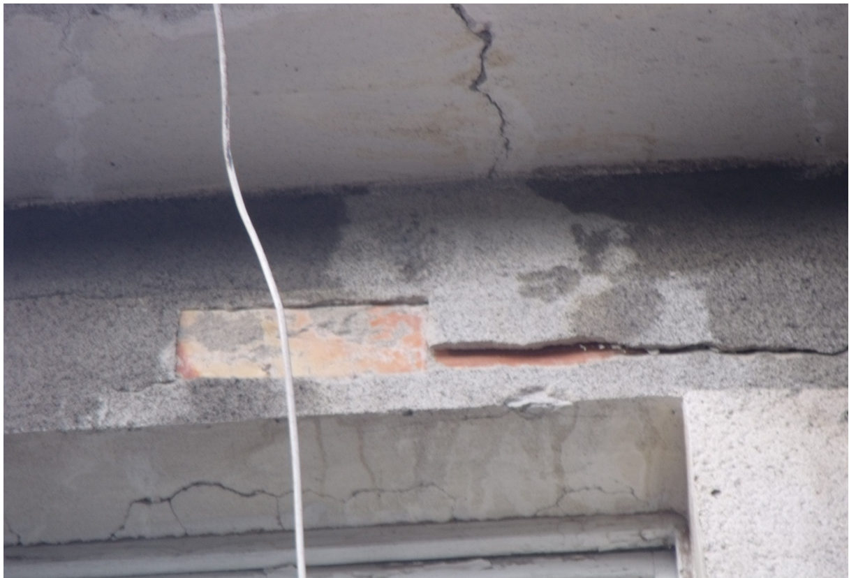
Fot.4.Widok nadproży i gzymsu na ostatniej kondygnacji budynku. Widoczne zarysowania na skutek ruchów termicznych stropodachu w związku z brakiem izolacji i dylatacji.
