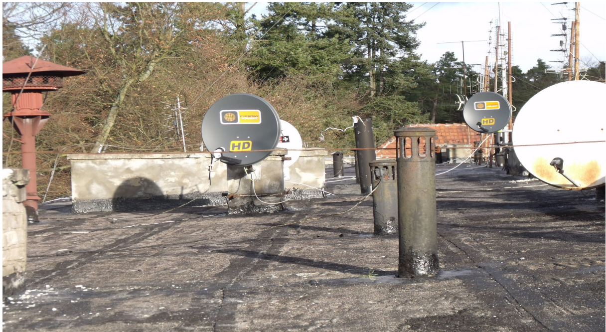
Fot.5.Widok dachu budynku. Widoczne pęcherze i odspojenia pokrycia z papy smołowej na nierównym podłożu oraz duża ilość anten satelitarnych stanowiących źródła przecieku.
