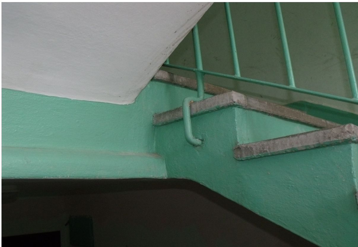
Fot.8.Widok żelbetowej konstrukcji schodów w dobrym stanie technicznym.
